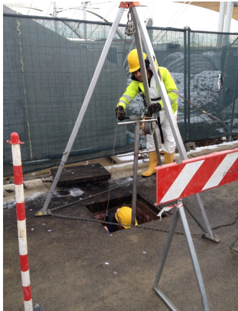
Fig. 12: Esempio di estrazione di un lavoratore privo di coscienza durante una simulazione di una emergenza
