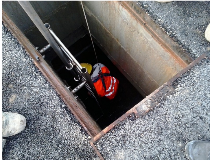
Fig. 11: Esempio di estrazione di un lavoratore privo di coscienza durante una simulazione di una emergenza
