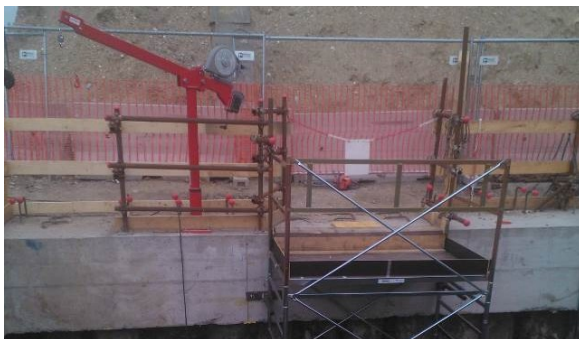
Esempio di recuperatore a braccio e castelletto di discesa
