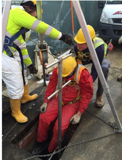
Fig. 13: Esempio di estrazione di un lavoratore privo di coscienza durante una simulazione di una emergenza
